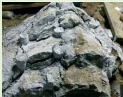
Desobstrucción en la cueva de Ekain. Rotura de una piedra y efectos de la rotura en el bloque a la hora y a las 3h.
