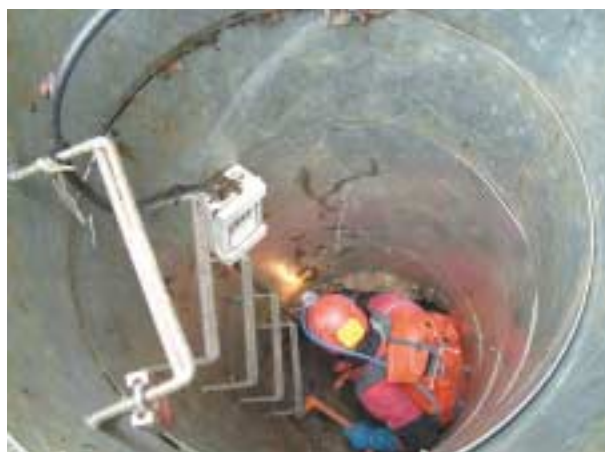
Entrada de la galería 53 y diferentes mediciones con los medidores de temperatura "Dataloger".
