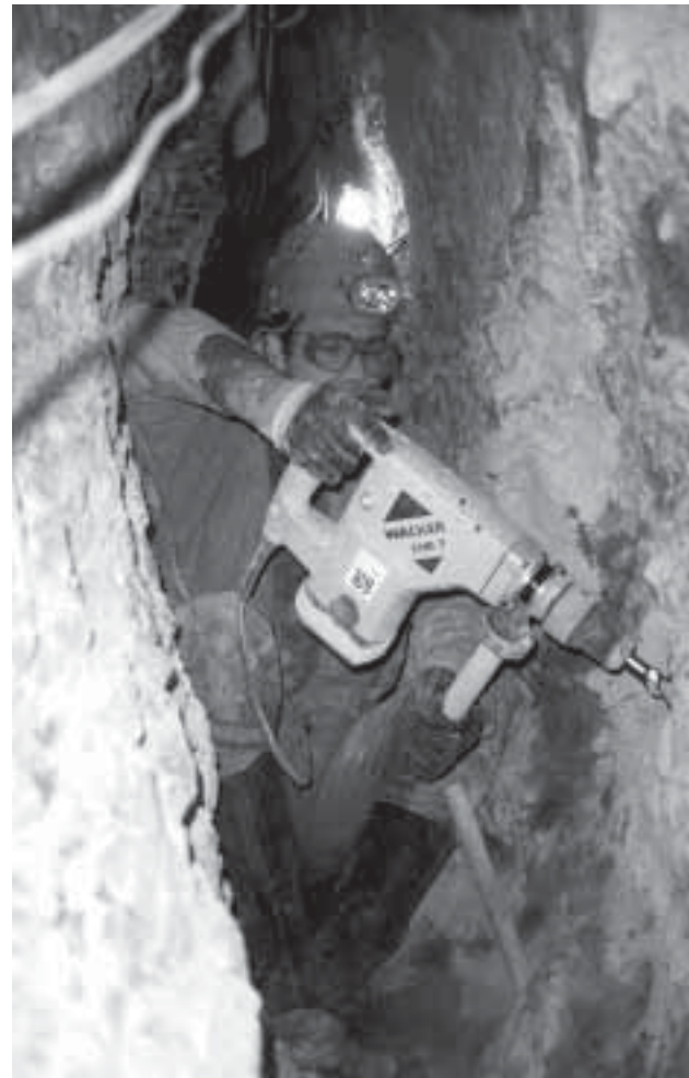
Labores de desobstrucción
